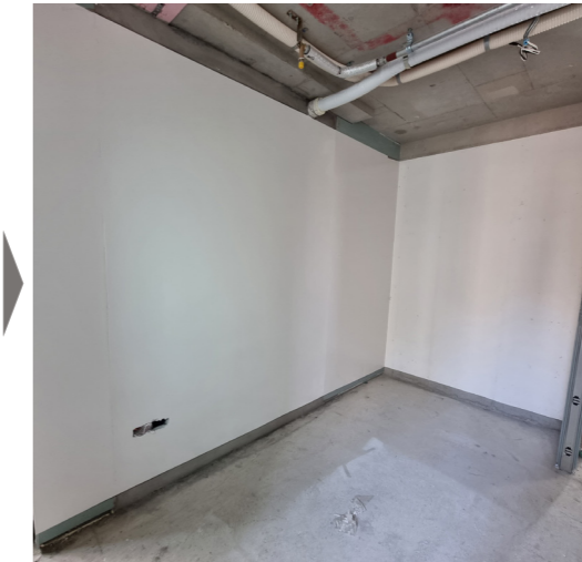
도배 등 마감재 시공 전 무기질도료 시공
