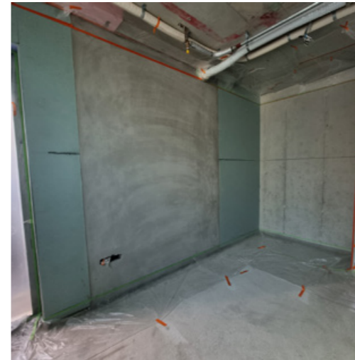
도배 등 마감재 시공 전 무기질도료 시공
